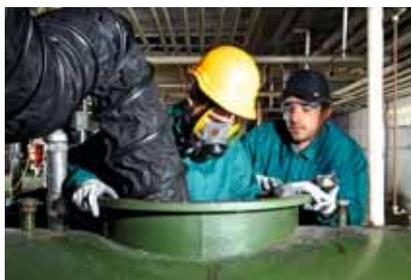
1 Lavori di molatura in una cisterna pulita: ventilazione e protezione delle vie respiratorie sono necessarie
