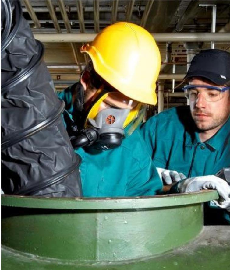
Per evitare esplosioni e intossicazioni negli spazi ristretti utilizziamo un ventilatore di aspirazione.
