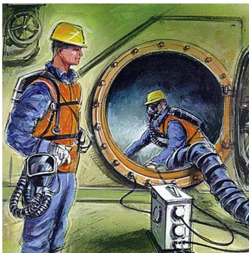
Nur so darf in Behältern und engen Räumen gearbeitet werden: Mit Entlüftung, Atemschutzgerät, Messung der Luftqualität und Überwachung durch eine zweite Person.
