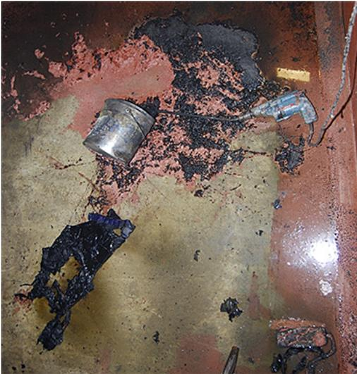
Die Auffangwanne wurde nicht mit dem Absaugventilator entlüftet und es bildete sich eine explosionsfähige Atmosphäre. Es kam zur Explosion, als der Mitarbeiter die lösemittelhaltige Grundiermischung mit einer Bohrmaschine mit Rühraufsatz mischte.
